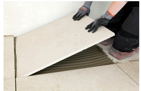
Med PCI Carrament Grå kan naturstensbeläggningar läggas säkert med hjälp av mellanbäddsmetoden.
