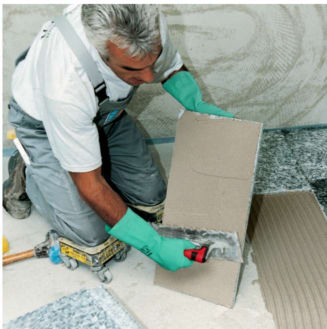
Dubbelimma naturstenen vid läggning utomhus, så att full kontakt erhålles och inga hålrum bildas under stenen.
