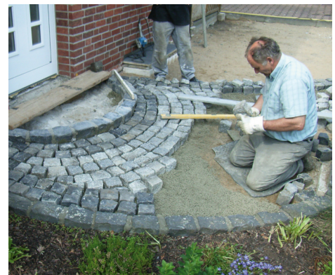
Läggning av smågatsten, i bruksbädden, PCI Pavifix DM.
