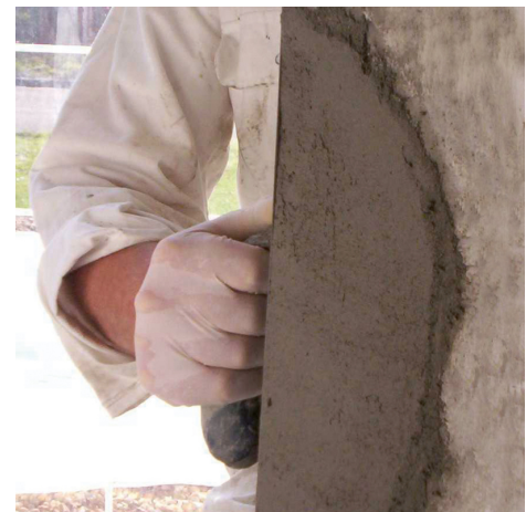
Reparation av hörn och kanter – bara ett av många användningsområden för universalbruket PCI Nanocret R2.
