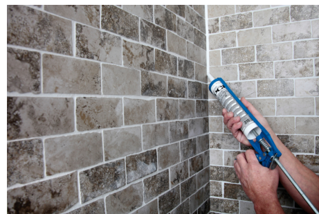
Användningen av PCI Carraferm resulterar inte i någon missfärgning av naturstens kantzoner.
