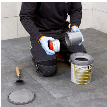
Öppna PCI Durapox Premium (Multicolor) (2 kg) och ta ut den andra komponenten.
