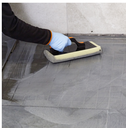
Efter ca 10—45 minuter ska den fogade ytan torkas av med en svampbräda och tvättas ren.
