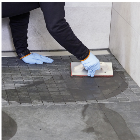
Mycket enkel fogning utan restsikt med PCI Durapox Premium.
