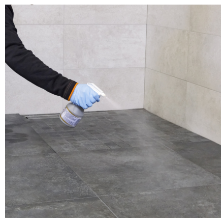
Före den avslutande tvättcykeln ska PCI Durapox Finish (flytande) sprayas på ytan efter ca 60 min.
