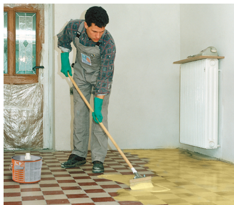
PCI Gisogrund 303 är den säkra primern för beläggningar på befintliga keramiska plattor.
