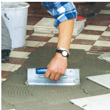
4. Beläggning kan läggas på primern efter ca 30–45 minuter.
