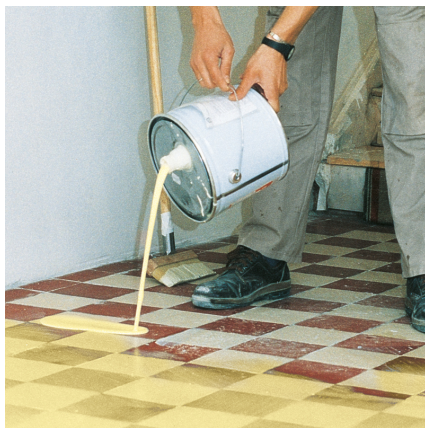
2. Skaka PCI Gisogrund 303 noga före appliceringen och håll produkten på underlaget.
