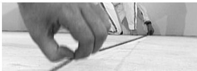
Markering av skiljeväggens placering med en snörslå.
