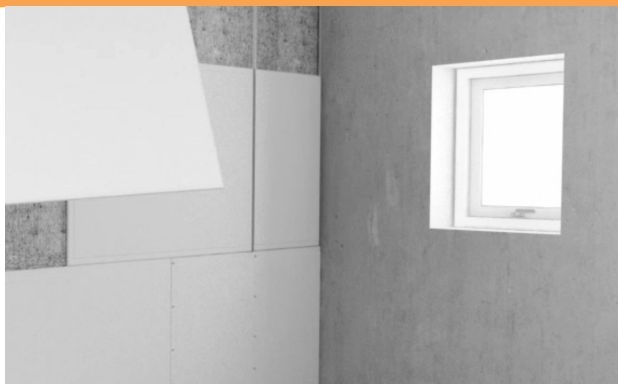
Montering av små skivor på underkonstruktion
