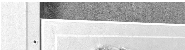
Skarvning av fibergipsskivor med spackelkant.
