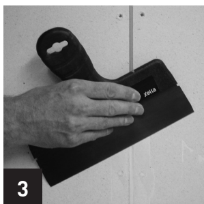
Spackla med fermacell fogspackel och låt det torka.
