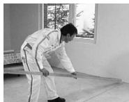
Lägg C-profilen/skenan på golvet.
