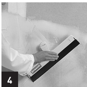
Efterspackla med finspackel
