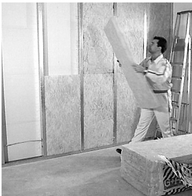
Montering av mineralull
