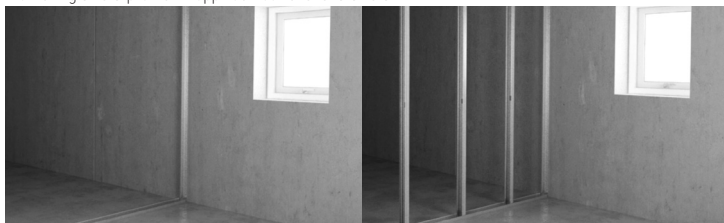
Montering av stålprofiler i topp- och bottenskena av stål.
