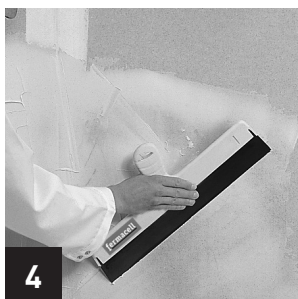
Efterpackla med t. ex fermacell finspackel.
